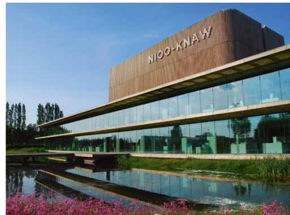
De grote vijver zorgt samen met een helofytenfilter, een sloot en een wadi waar het regenwater van het verharde parkeerterrein in wegstroomt, voor een goede waterhuishouding op het terrein.
