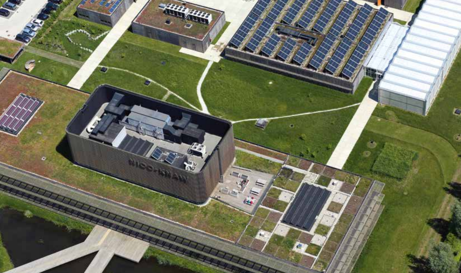
Op het dak van het NIOO-gebouw worden verschillende gemengde sedumvegetaties en substraten beproefd.
